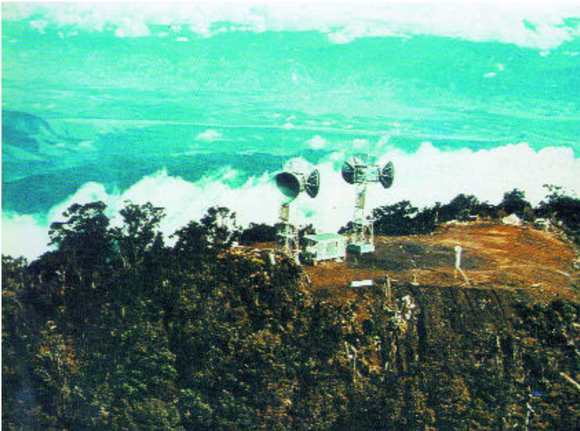
Stazione ripetitrice nodale in Nuova Guinea, realizzata all'inizio degli anni Settanta con apparati radio della Telettra IR-20 ("Injection Repeater"), situata a 2500 metri di altezza e raggiungibile solo in elicottero. Caratteristica peculiare dell'IR-20 era il consumo assai ridotto: due ordini di grandezza inferiore rispetto agli apparati radio dell'epoca.
